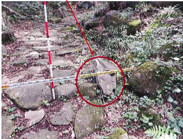
写真2 道路側溝への落石 横50cm縦70cm
