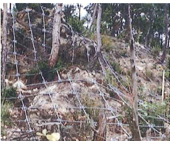
写真5 標準の亜鉛アルミメッキのロープネット工 施工例
