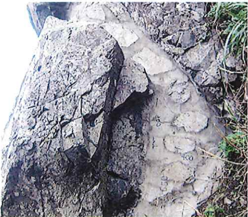
写真6 岩盤接着工 （DKボンド工法）
