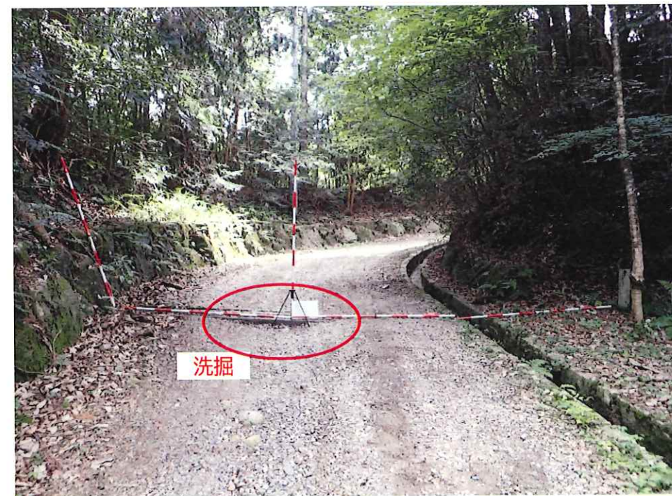
起点より+38.00m地点
