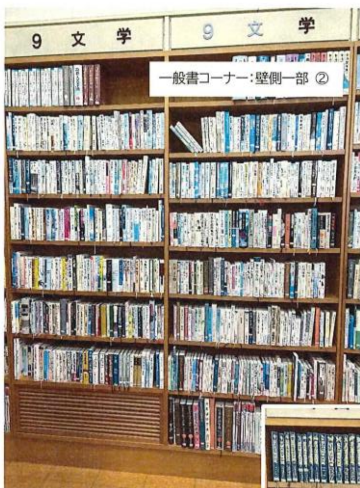
② 下部に空調関連のスペースが設けられている棚
