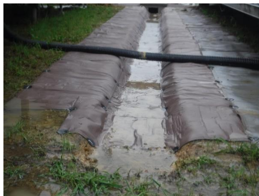
写真 5-3 素掘り側溝_設置イメージ (2)
