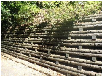
写真 5-8 ①丸太組み
