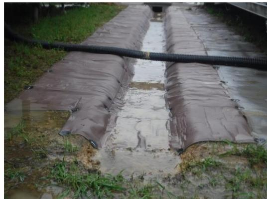
写真5 素掘り側溝\_設置イメージ
