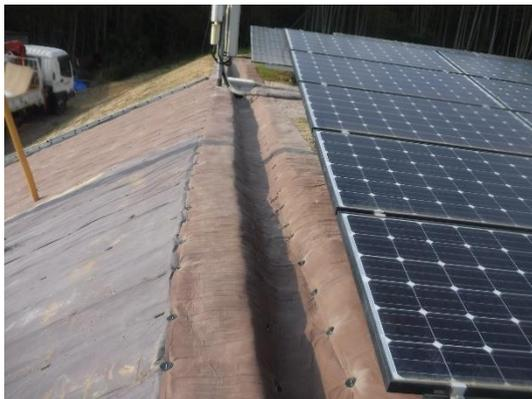
写真4 素掘り側溝\_設置イメージ
