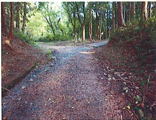
写真9 緩斜面部_現況
