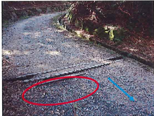
写真2 急斜面部_現況
