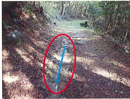
写真5 西側地道部_現況
