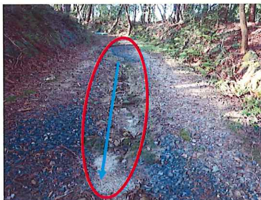
写真 15 急斜面部_現況
