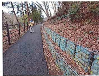
写真8 法面对策 植生土のう
