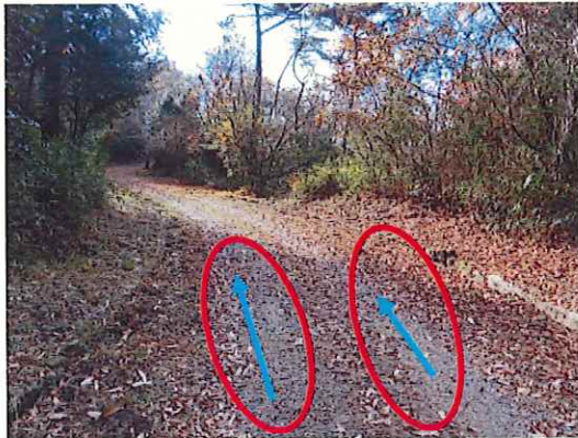
写真1 緩斜面部_現況
