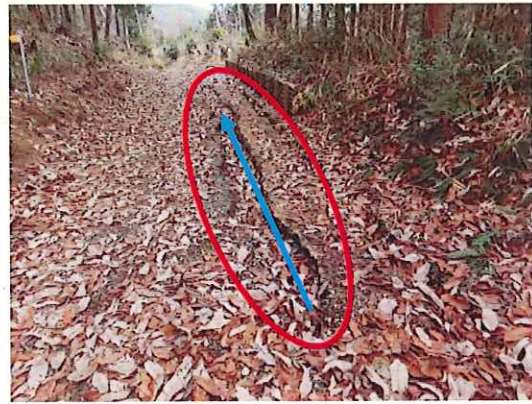
写真10 急斜面部_現況
