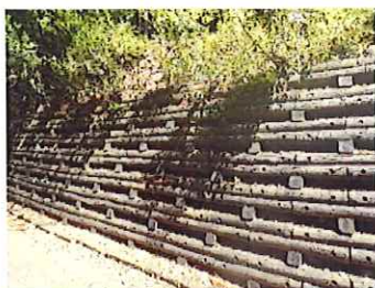
写真6 法面对策 丸太組
