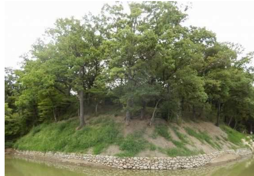
図 7 植生シート施工事例(施工後 6 カ月) (国史跡・武田氏館跡（甲府市）)
