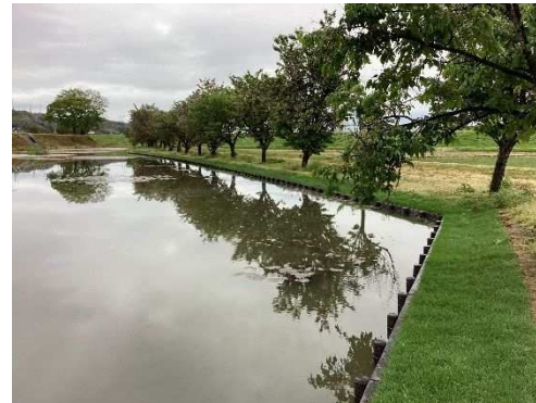
図 8 植生シート施工事例（施工後 1 年） (国史跡・安田城跡（富山市）)
