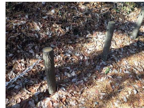
図 12 奥之田一里塚 破損状況
