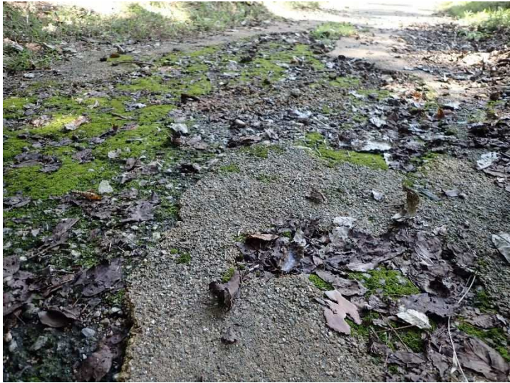
写真 13 一般部（過年度敷設舗装）
