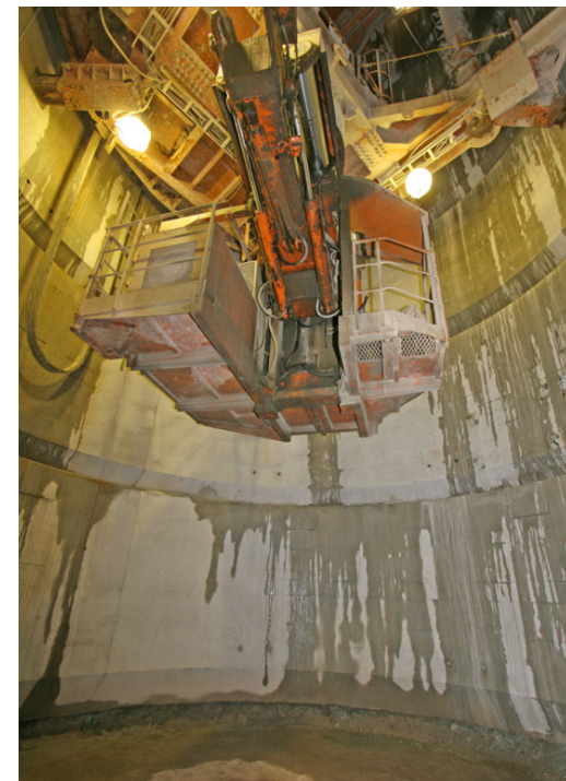
【主立坑（深度459.6m）】
