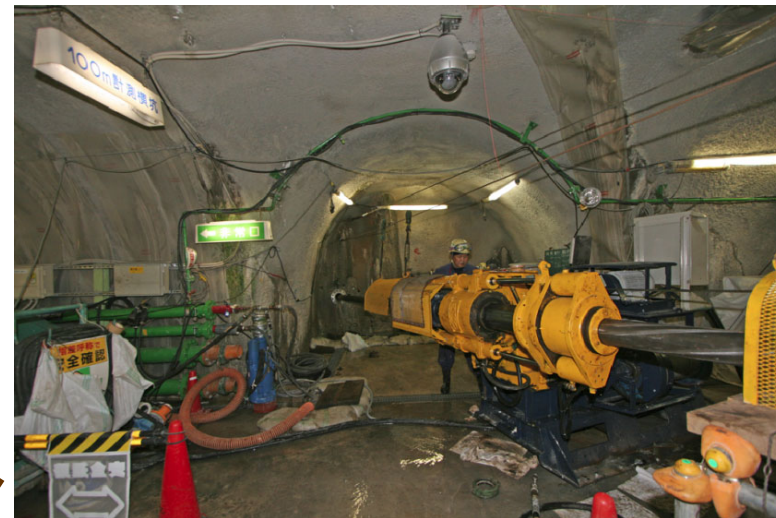
断層や割れ目帯を対象としたボーリング調査
