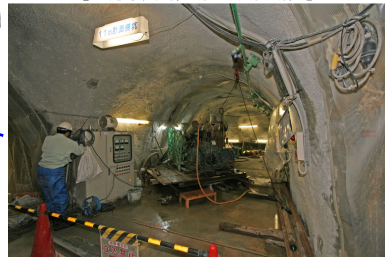
物質移動特性調査・評価技術の開発におけるボーリング調査
