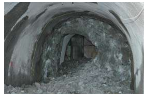
水平坑道貫通
