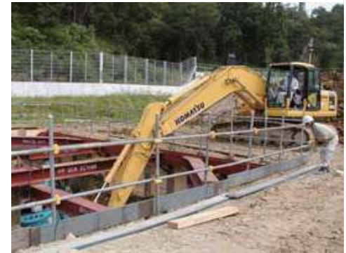
立坑(坑口)掘削工事
