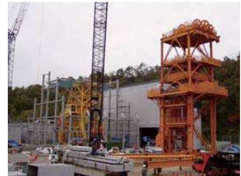
橋設備設置工事
