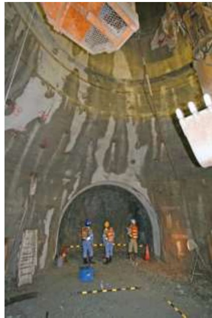
【主立坑(深度500.2m)】
