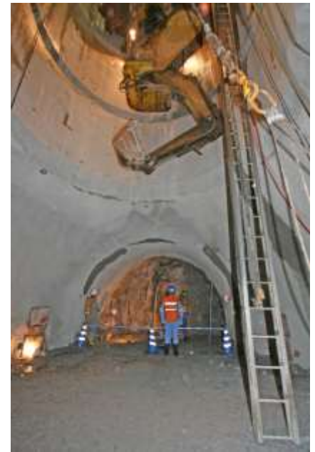
【換気立坑(深度500.2m)】
