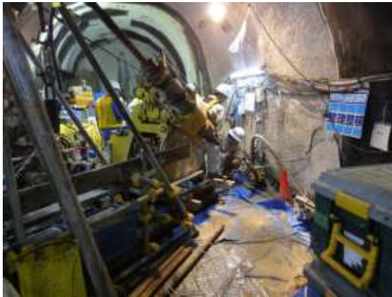
【岩盤中の物質の移動に関するボーリング孔】 電力中央研究所との共同研究(平成24年度掘削)
