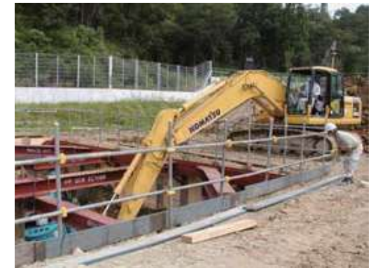
立坑(坑口)掘削工事
