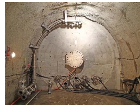
深度500m研究アクセス北坑道 (止水壁)
