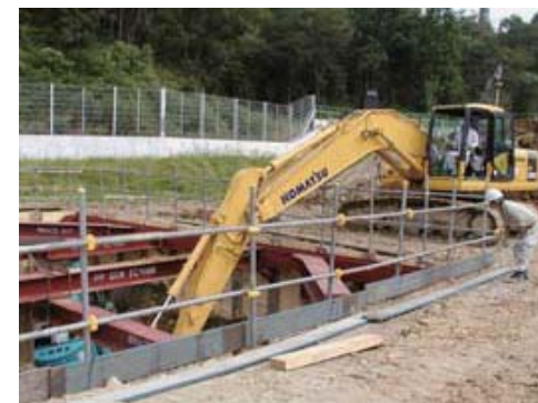
立坑(坑口)掘削工事
