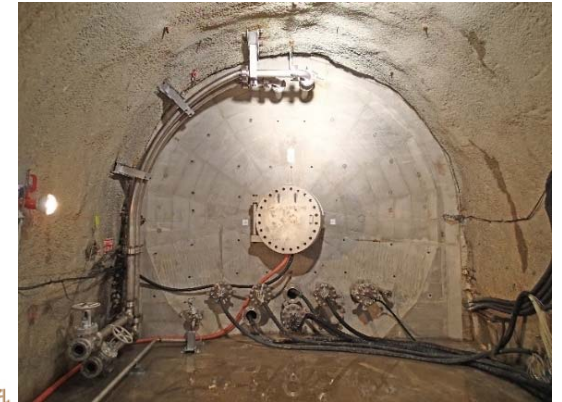
【冠水坑道(止水壁)】
