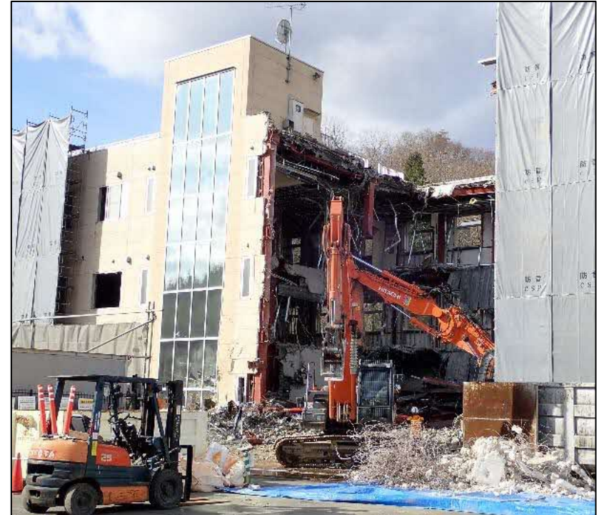
管理棟の解体作業
