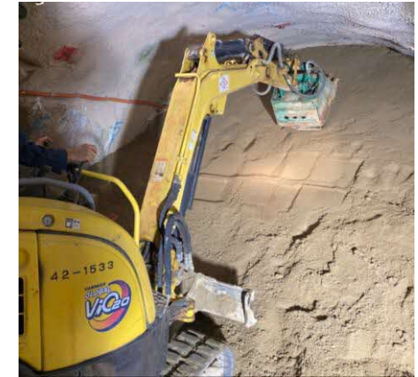
深度400m予備ステージ 埋め戻し作業
