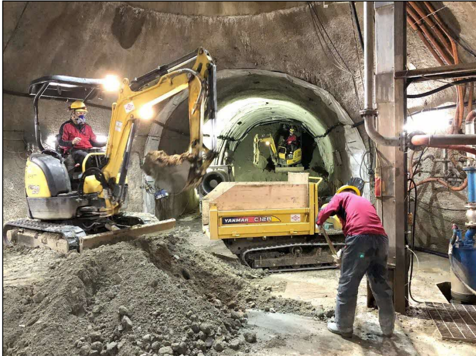
換気立坑接続部(深度500m)付近の埋め戻し作業
