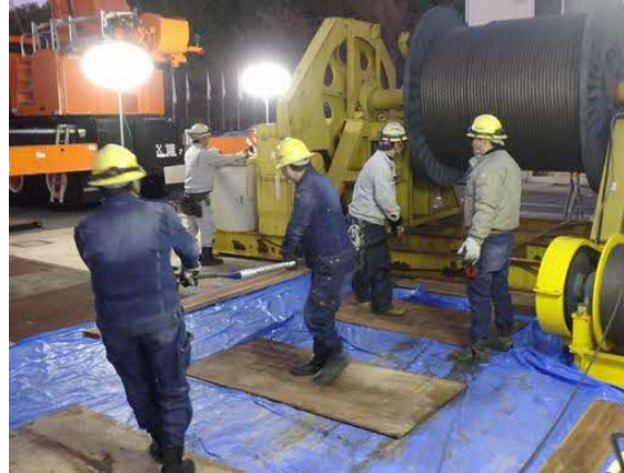
換気立坑巻上設備のワイヤーロープ (スcaffolding)の交換作業
