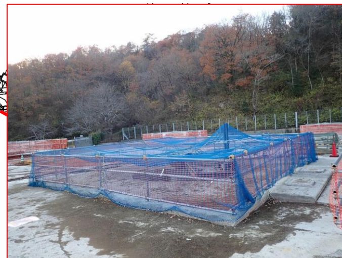
換気立坑口 安全ネット設置状況
