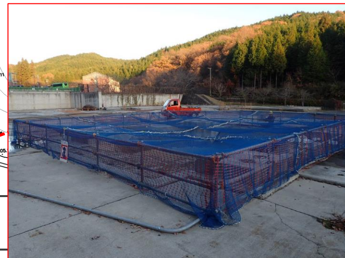
換気立坑口 安全ネット設置状況
