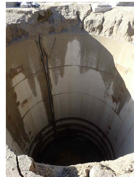
2023/11/21 総沈下量12.7 m 変化なし→
