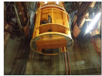
•キブルを地上から立坑坑底へ運搬
