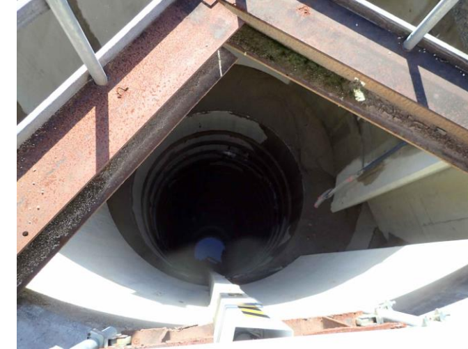
2023/11/21 総沈下量 26.8 m
