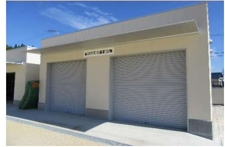
瑞浪北中学校防災倉庫
