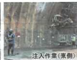
注入作業(東側)
