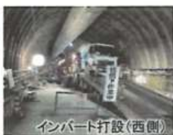
インバート打設(西側)
