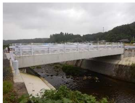
落合橋 (橋長:18.6m 竣工年:令和 2 年)
