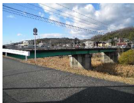
松ヶ瀬橋 (橋長:73.2m 竣工年:昭和 47 年)
