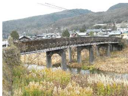
大島橋 (橋長:43.7m 竣工年:昭和 6 年)
