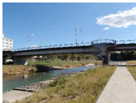
竜門橋 (橋長:85.1m 竣工年:平成元年)
