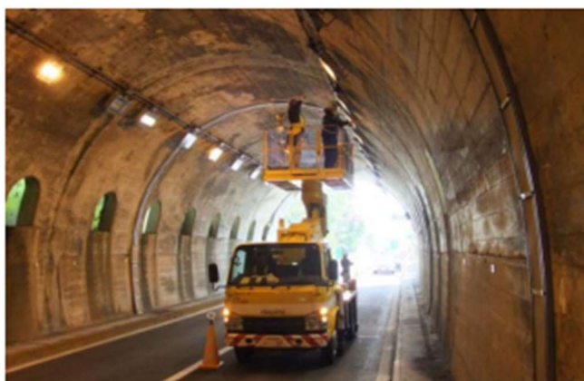
図 3 近接目視作業状況
