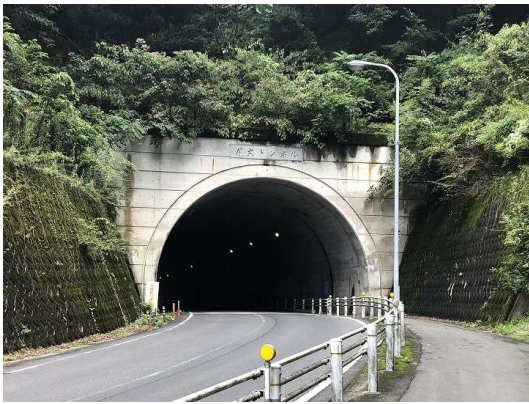
月吉トンネル(始点側)
