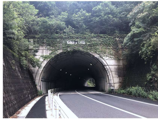
月吉トンネル(終点側)
