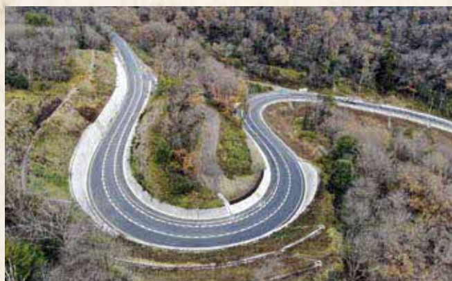
▲雨降り峠道路完成(日吉町)
