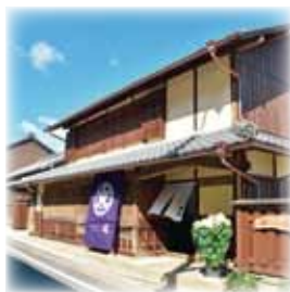
▲旧森川善章家住宅（現在、古民家カフェとして活用）
