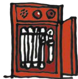
屋内消火栓設備
