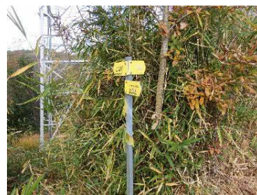
3. 管理用標識（中部電力）
