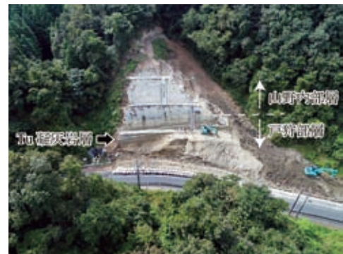
工事に伴って出現した地層、2020 年 9 月 30 日撮影
