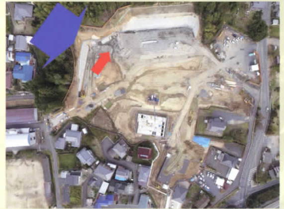
①造成工事現場の航空写真、現場直上から撮影
