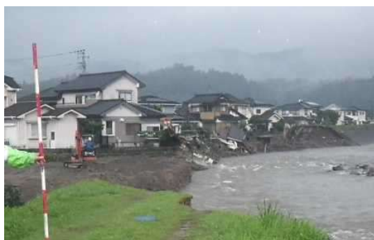
河岸侵食による家屋の倒壊(花月川)
