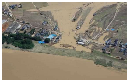
堤防決壊による家屋の流失(鬼怒川)
