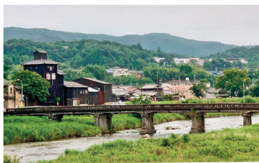
撤去された土岐橋
