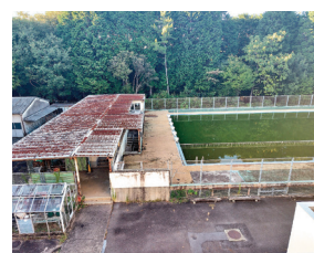
使用停止しているプール施設
