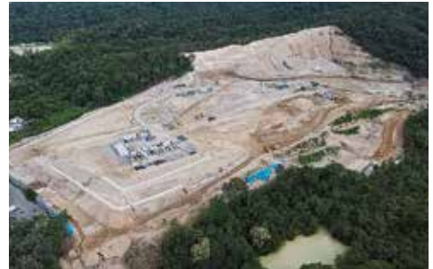
新病院建設地の造成工事の様子
