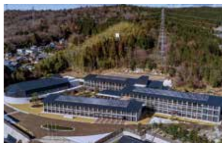
北中学校の太陽光パネル
