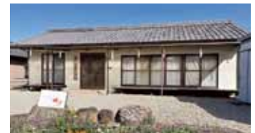
新たな通いの場となる旧稲津宅老所
