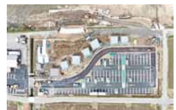
建設中のバーベキュー場
