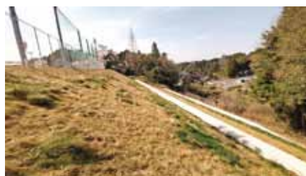
稲津小学校北法面盛土復旧箇所
