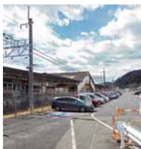
駅北側の現状
