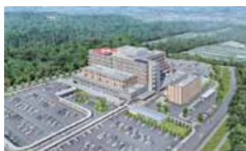
建設予定の東濃中部病院
