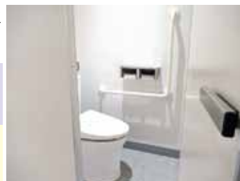
令和2年に洋式化に改修した 釜戸小学校のトイレ
