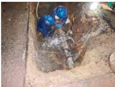
老朽化により漏水した水道管
