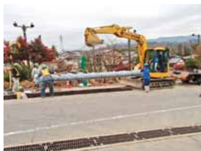
耐震管の布設工
