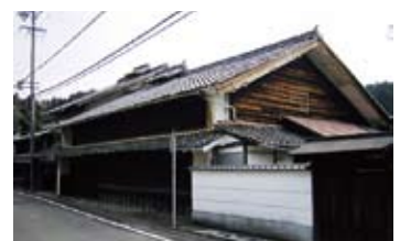
改修前の旧森川訓行家住宅
