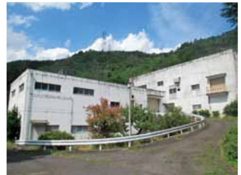
解体される衛生センター
