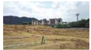
稲津小学校 グラウンド工事の様子
