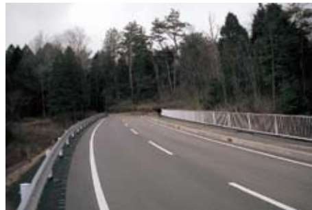
水洗・中学校線完成部分
