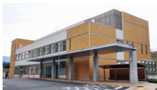
竣工した保健センター
