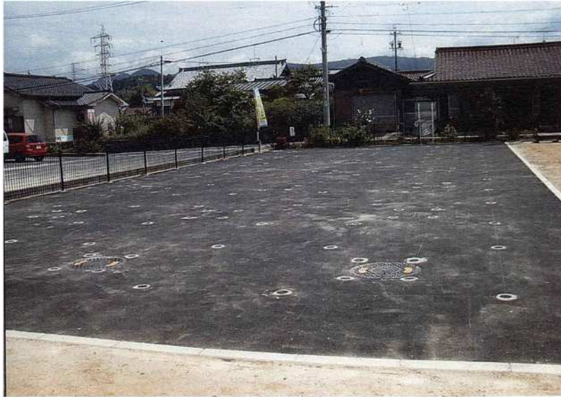
瑞浪中央公園グラウンド内設置状況
