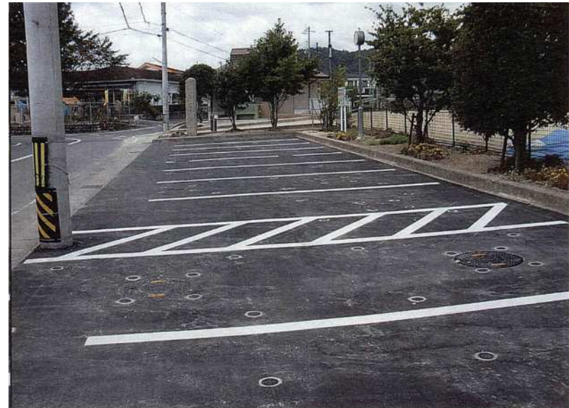
西駐車場設置状況
