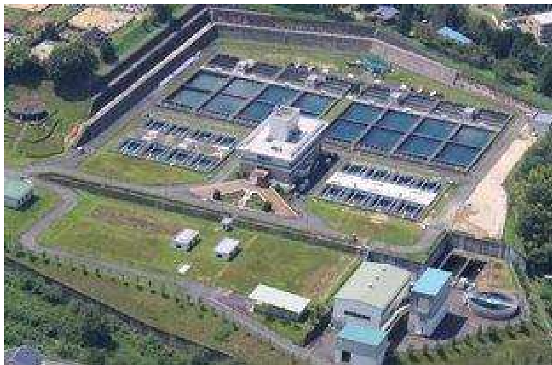
中津川浄水場
