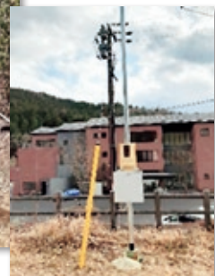
▲電気設備を設置
