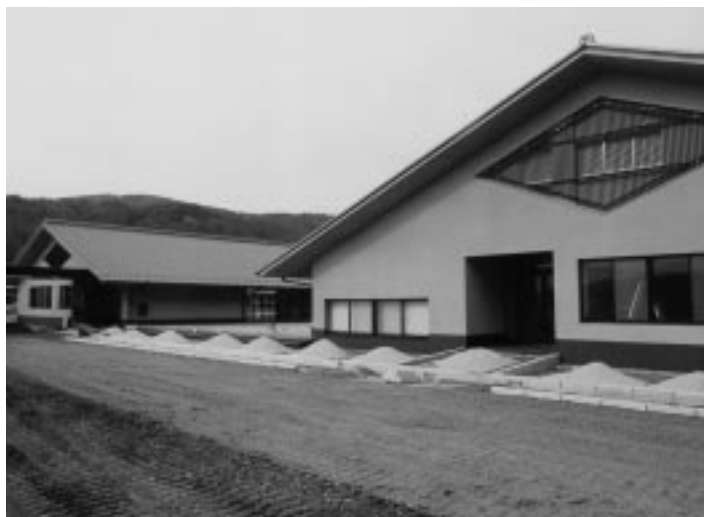
急ピッチで建設が進む釜戸コミュニティーセンター
