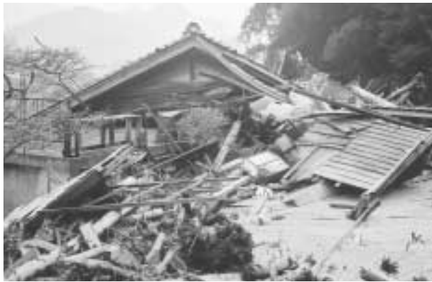
家屋の倒壊（平成12年9月 写真提供 恵南消防組合）
