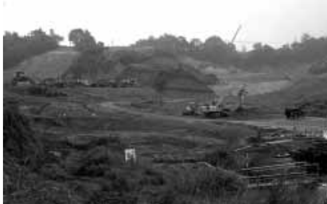
▲工事が進む瑞浪クリエイション・パーク
