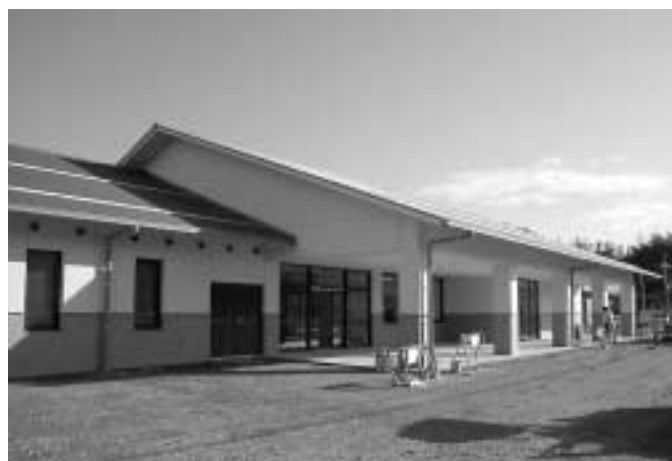
完成間近の身体障害者デイサービスセンター、老人憩いの家
