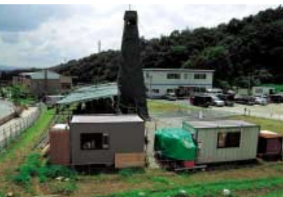
瑞浪超深地層研究所建設工事着工
