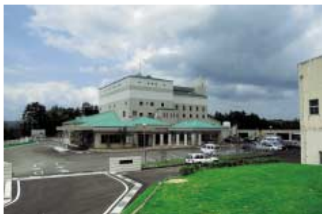
新クリーンセンター竣工
