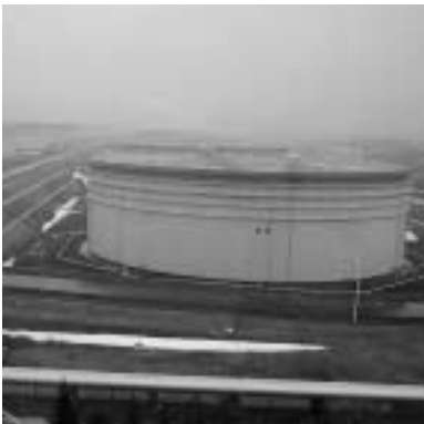
むつ小川原国家石油備蓄基地
