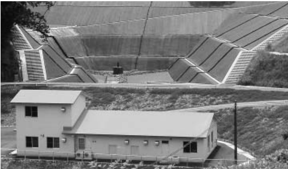
新不燃物最終処分場
