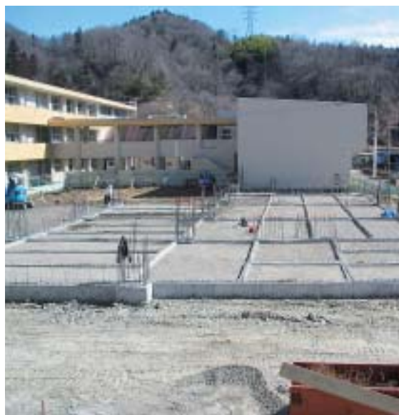
建設中の日吉中学校
