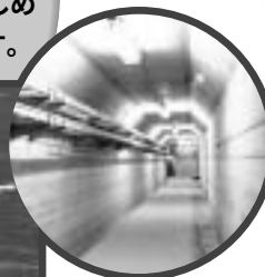
ダム本体の点検
