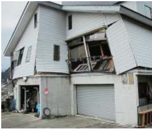
◀(写真1) 平成16年新潟県中越地震による家屋の被害(塩野計司氏撮影)
