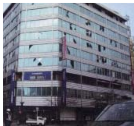
◀(写真2) 福岡県西方沖地震により、ビルの窓ガラスが多数割れて落下した。(九大自然災害資料センターニュースより)
