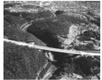
土岐川橋（仮称）
